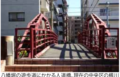
八幡堀の遊歩道にかかる人道橋。現在の中央区の楓川に架橋されていた。鉄を主材にした日本最古の橋
